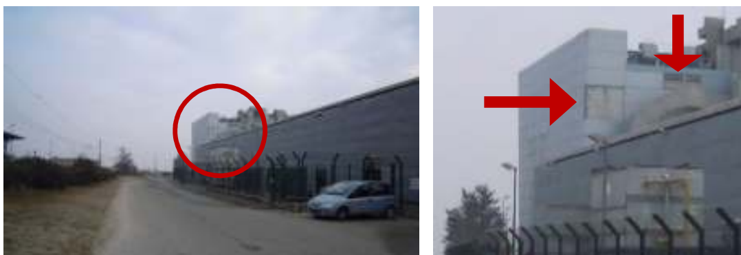
Fig. 1: Pannelli Alucobond non presenti in facciata
